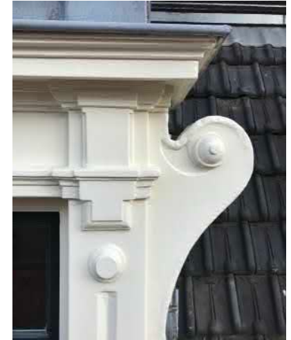
↑ schilderwerk dakkapellen zijde Marnixstraat
